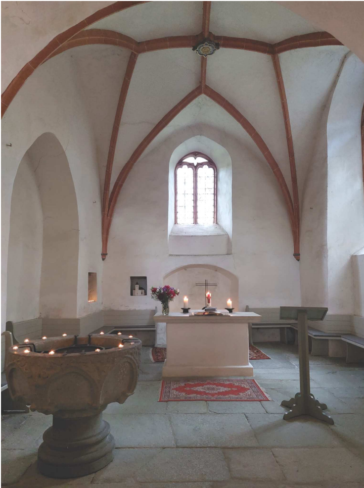
Sterngewölbe des Chorbogens
